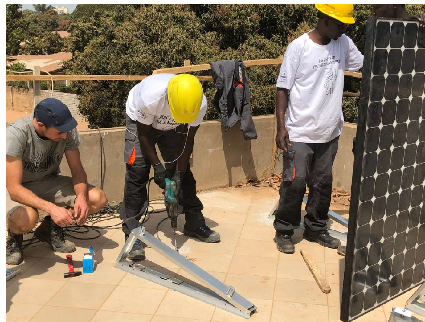
Installation de panneaux solaires pour l'école "The Swallow" en Gambie.
